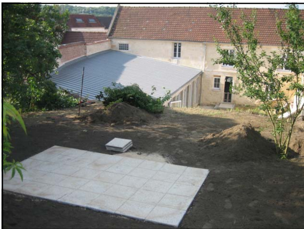
Façade arrière avec la salle multifonctions vue depuis la partie haute du terrain (avant finitions)
