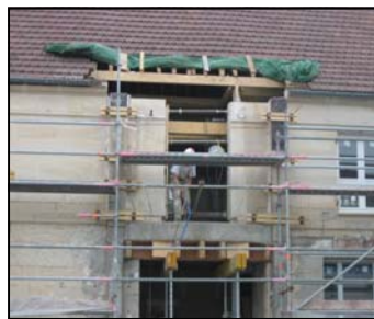
Façade avant pose
