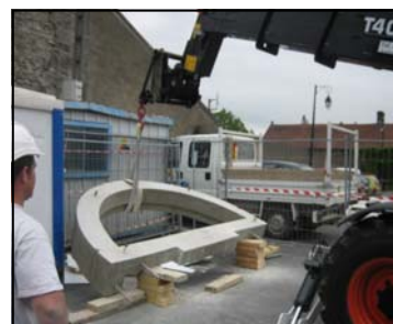
Relevage de la pièce
