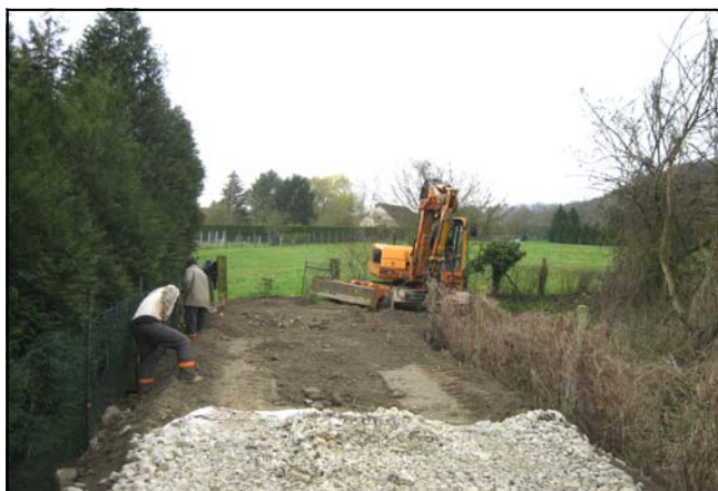
empierrement du chemin après la pose des canalisations
